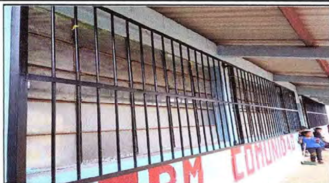
Foto 1: Vista frontal del establecimiento en donde se observa el 100% de la colocación de los dos balcones.
