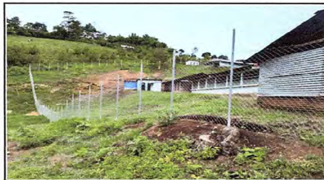
Foto 3: Se observa el 100% de la Circulación con malla y remodelación de muro perimetral del establecimiento.
