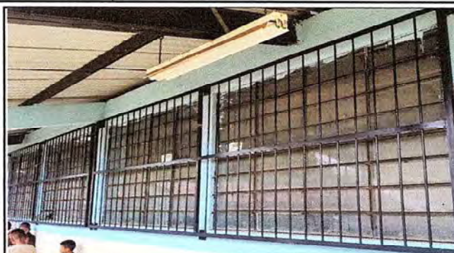
Foto 2: Vista lateral de la otra escuela en donde se observa el 100% de la colocación de los balcones.
